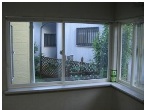
角の窓に2つ、プラマードUを取り付けました
