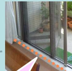
内側の木枠に網戸用のレールを取り付ける
